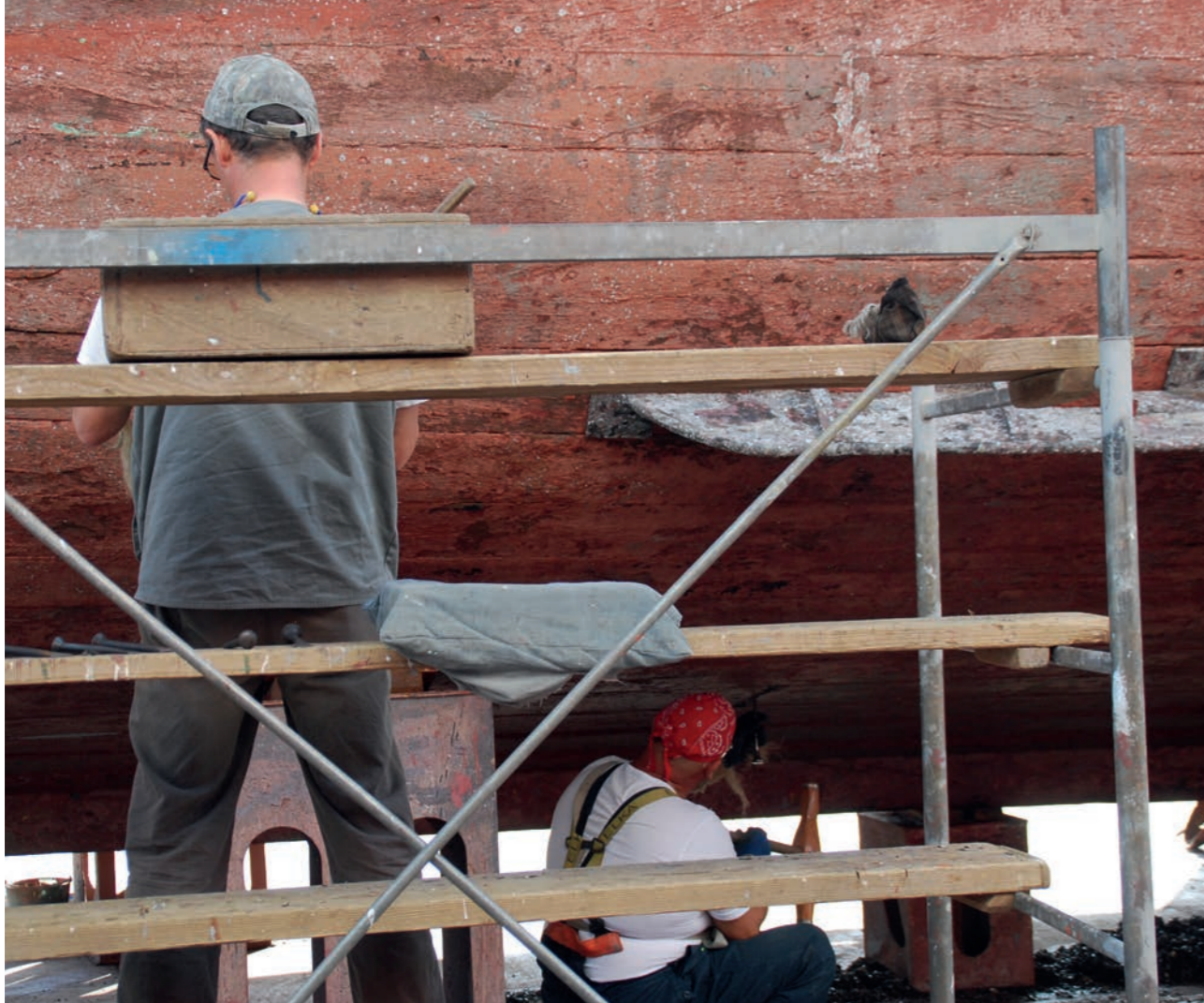
Le lavorazioni intorno alla carena.
